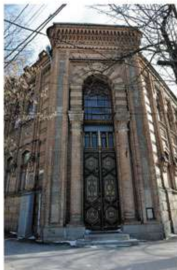
Міська лікарня № 3. м.Кіровоград, вул. Дворцова, 45 Пам'ятка архітектури - Водолікарня Гальденберга. Кін. 19 ст.
